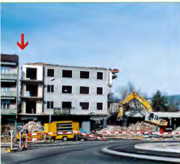
Zusammengebaute Gebäude müssen vorgängig getrennt werden
