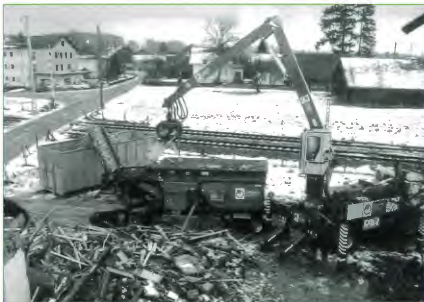
Altholz-Entsorgung – im Rückbau ein wichtiger Bestandteil
