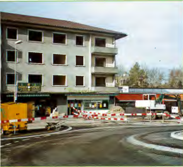
Zum Rückbau vorbereitete Objekt
